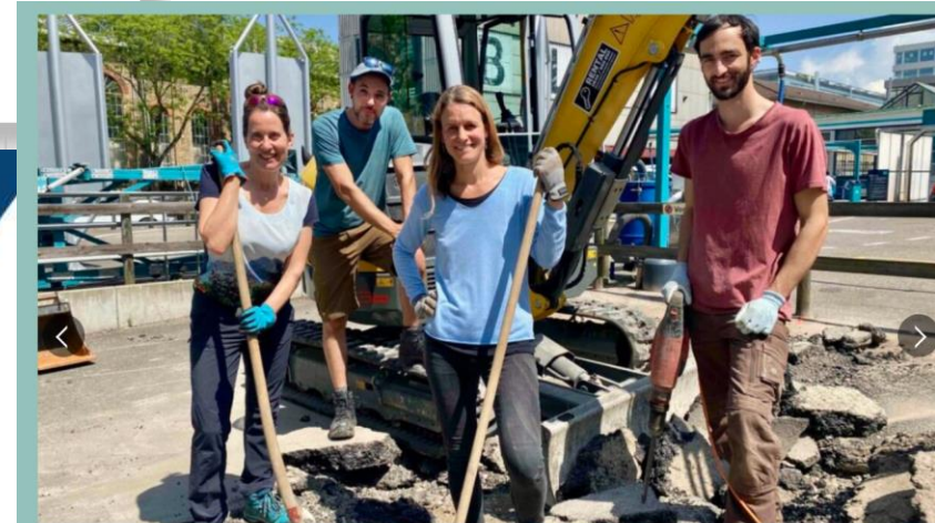
Die Asphaltknackerinnen am Start
